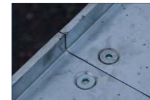
Lastplatte verschraubt versenkte Schrauben Lastplatte feuerverzinkt
