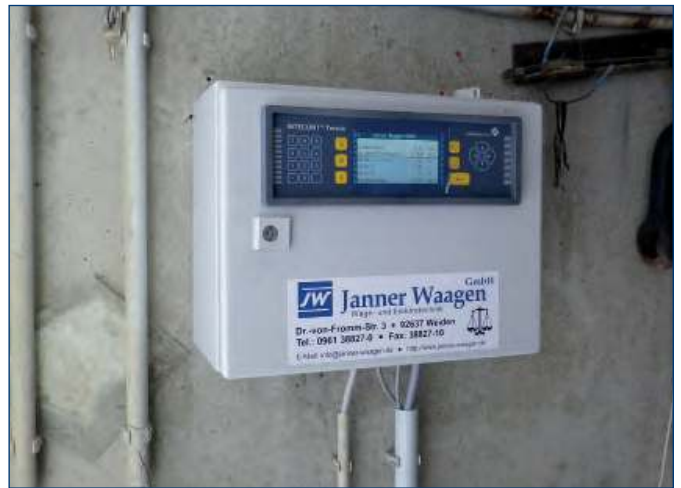
Auswertegerät im Schaltschrank
