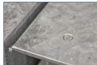
Lastplatte verschraubt versenkte Schrauben
